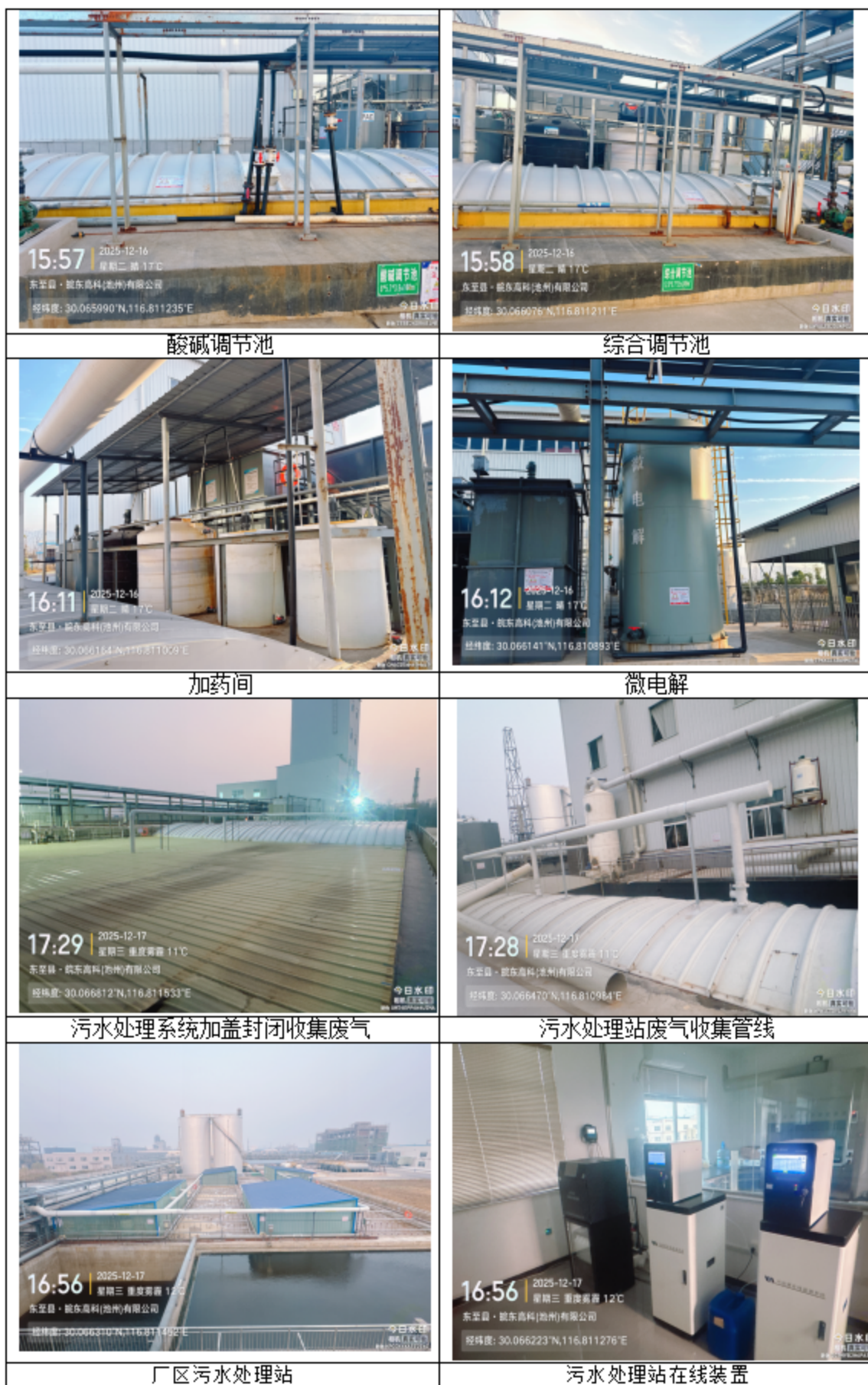
图4.1-4 本项目污水处理站设施示意图
