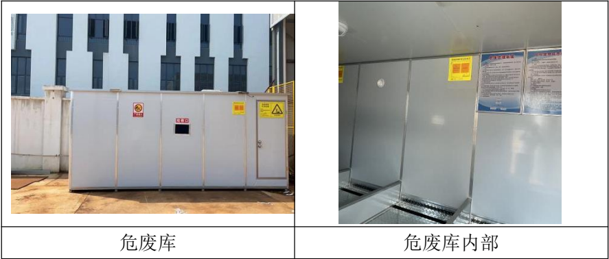
图 3-6 危废库现场照片
